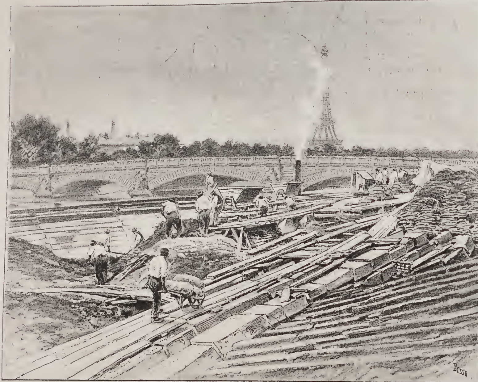
AU BORD DE LA SEINE. — Charriage du sable et de la chaux pour l'approvisionnement des bétonnières.
